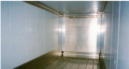
Innenraum eines Kühlcontainers
